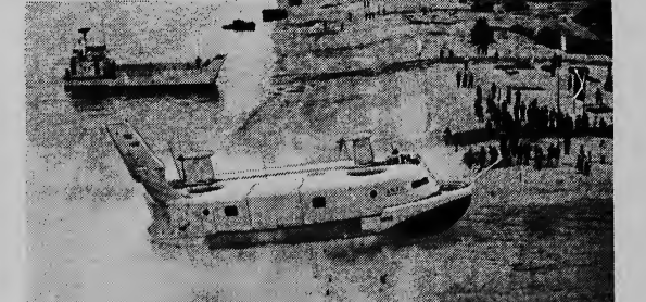
Un di e prueba nan e hovercraft tin mas ventaha cu otro vehiculonan pa baha tropanan for di laman na terra, ta e eliminacion di cu tropanan mester baha den laman na yega terra.
